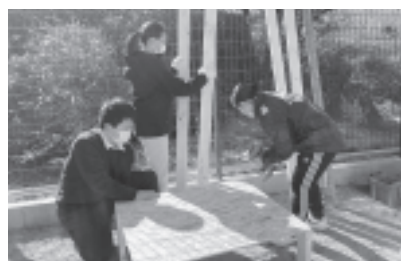
ドッグラン遊具の製作
